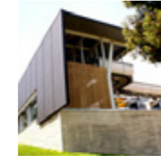
2005 Estaciones Teleférico de Montjuïc
