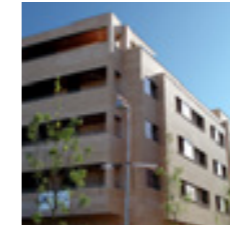
2007 Edificio Plurif. 42 viviendas alto atanding, St. Just Desvern
