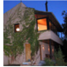
2002 Vivienda Unifamiliar, Cantonigròs
