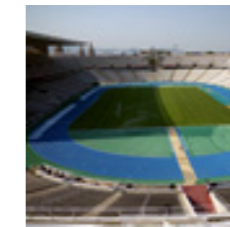
2010 Adecuación Estadi Olímpic Montjuïc
