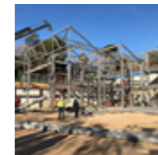
Ejecución Centro Cultural y Deportivo Can Vidalet, Esplugues
