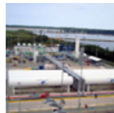
2014 Consolidación Planta Gas Natural, Ecuador
