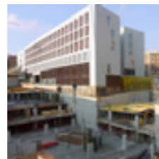
2011 Parking Soterrado 463 Plazas, Barcelona
