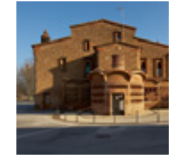
2009 Reconstrucción Pozo Ca L'Ordal, Colonia Güell
